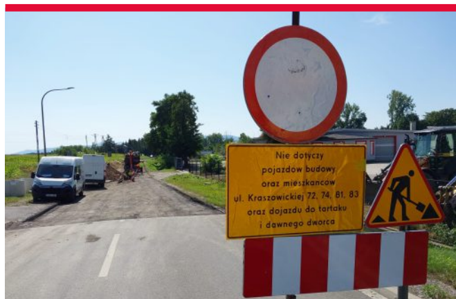
ul. Kraszowicka - etap III
